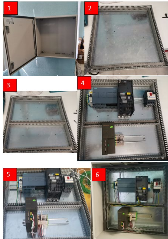
Figura 15. Instalación del gabinete y armado del tablero eléctrico.
