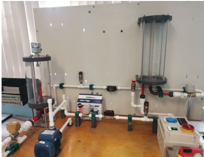
Figura 14. Instalación de sensores y salida del sistema de tubería.
