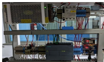
2) Instalando y Conectando el PLC.
